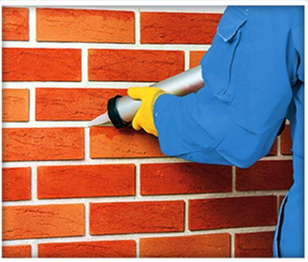
После окончания монтажа термопанелей выполняется затирка межплиточных швов. Для расшивки швов следует использовать специальную морозостойкую затирку для широких швов, рекомендованную производителем термопанелей. Работы производятся только при плюсовой температуре. Первый этап-очистка панелей от грязи и пыли. После завершения всех работ, необходимо чтобы в ближайшие 2-3 дня температура воздуха находилась в диапазоне +5 - +25С
